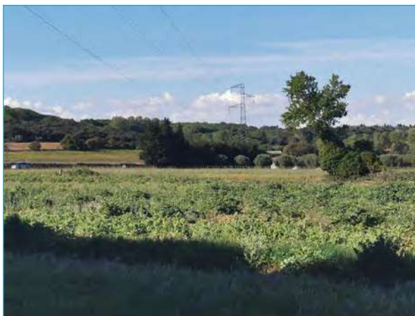
Ligne à 63 000 volts peu avant son arrivée au poste de JONQUIÈRES
