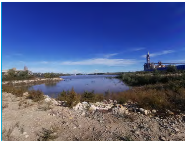
Franchissement du Rhône au niveau de l'entreprise Fibre Excellence
