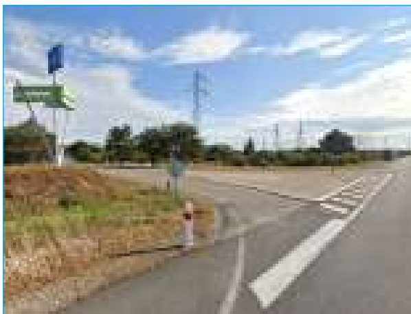
Couloir de lignes le long de la RD268
