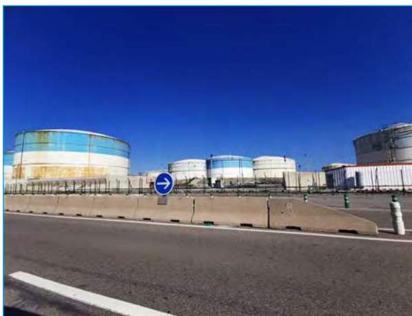
Réservoirs d'hydrocarbure dans la ZIP
